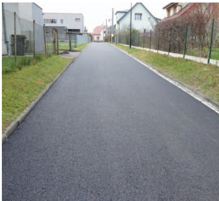
Nový povrch vozovky
