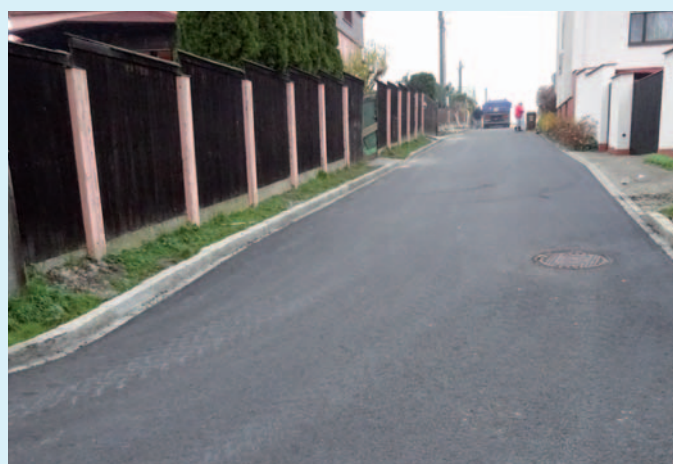
Komunikace po opravě
