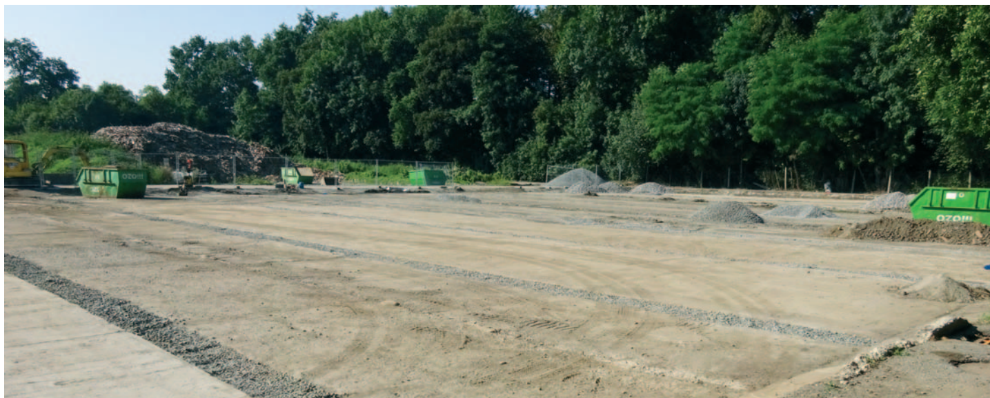
Příprava lokality na ul. Provozní pro sběrný dvůr
