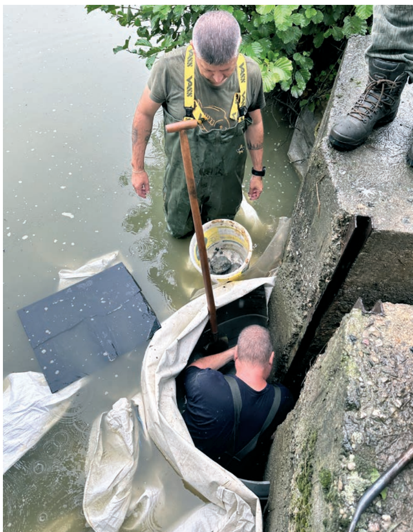
Práce na stavidle rybníku
