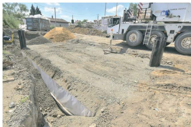
Uložena vsakovací nádrž
