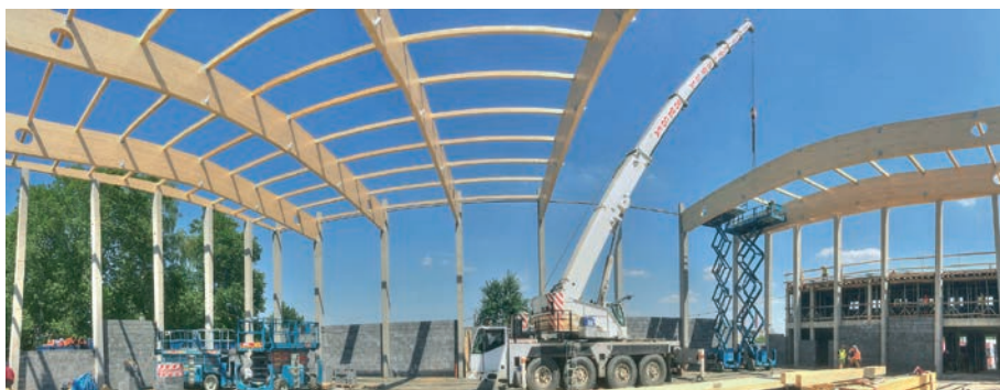
Montáž střešní konstrukce
