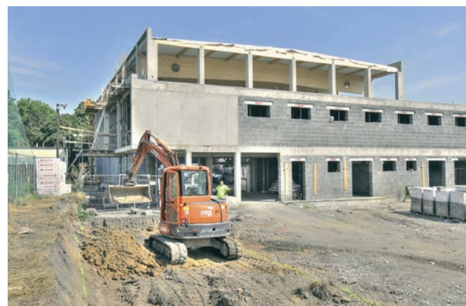
Pohled z jižní strany
