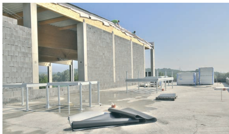
Dostavba štítové stěny
