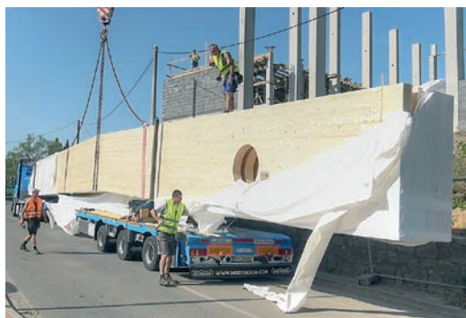
Dovoz stropních vazníků
