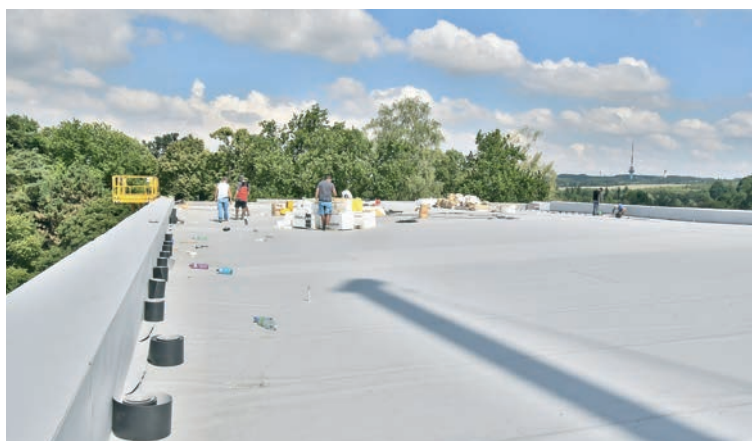
Montáž povrchové fólie střechy
