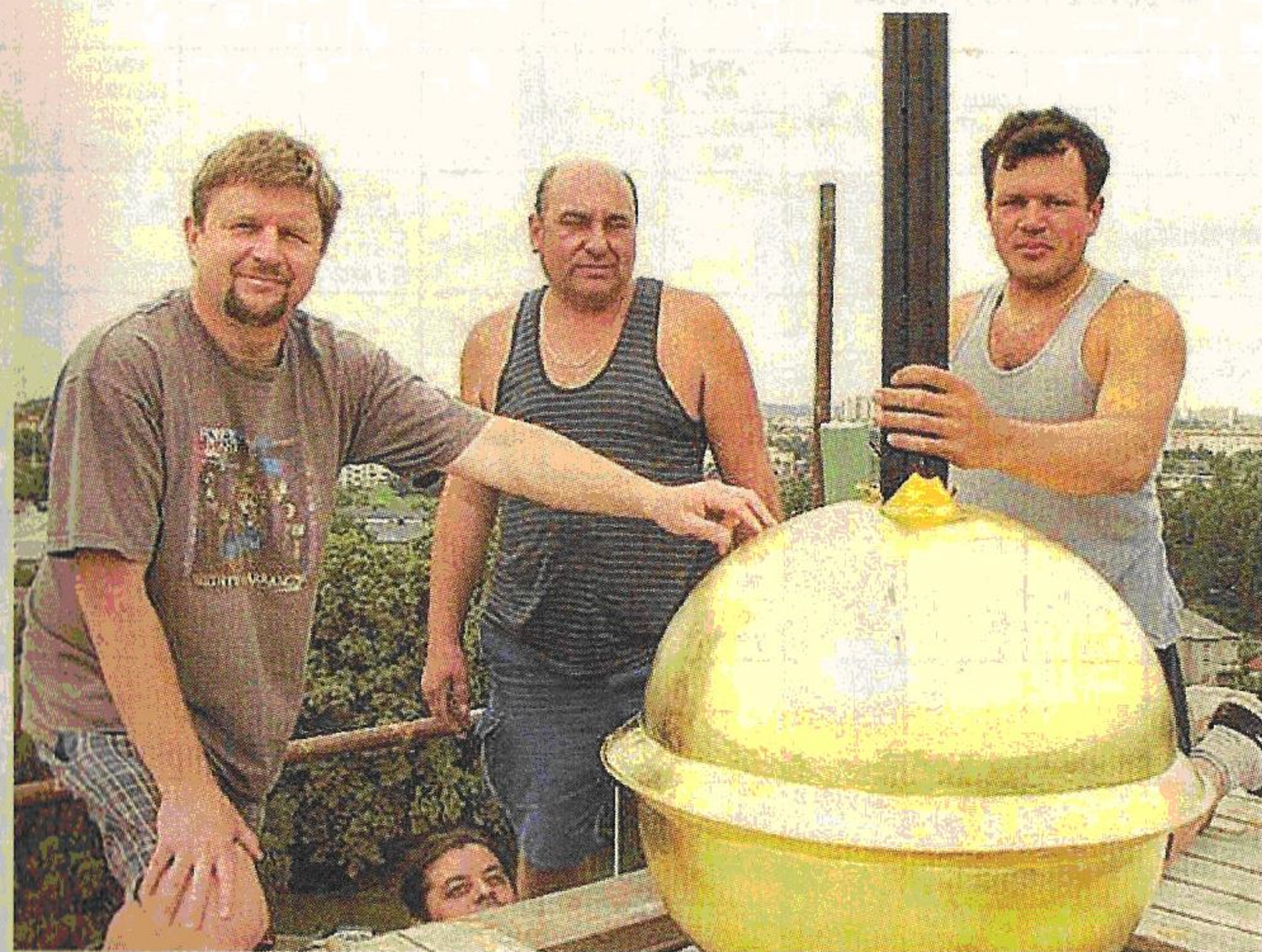
HOTOVÉ DÍLO. Báň kostela je usazena a dílo dokončeno. Na snímku jsou zleva Milan Hajlman, Jiří Ovesný a Marek Žucha, kteří pracují pro klempířskou firmu Stavitelství střechy z Hranic. Foto: Ladislav Kozubík
